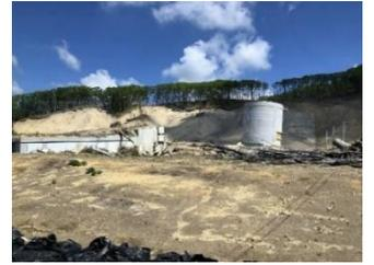
浄水場、タンクの横に立っていた建物が土砂で流された
